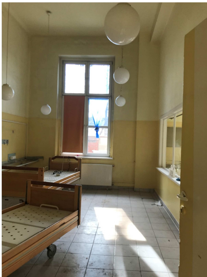
WNĘTRZE PRZEBUDOWYWANEGO ODDZIAŁU – sale łóżkowe
